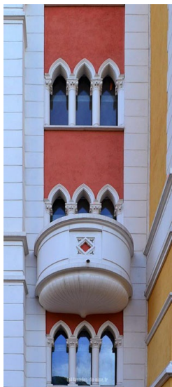
Front detail, château des Ollières.
